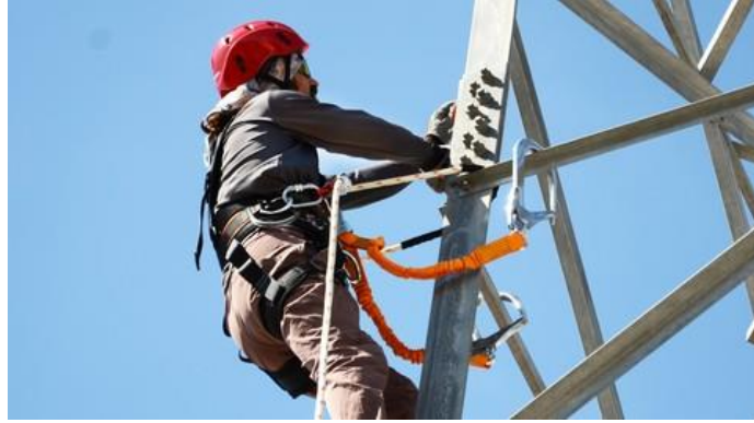
Şekil 17: YÜKSEKTE EMNİYET KEMERİ TAKMIŞ ÇALIŞAN
